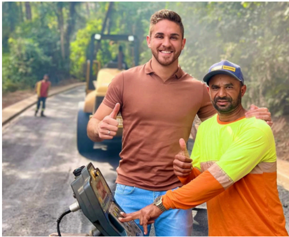
As ruas foram renovadas e já estão recebendo sinalização viária
